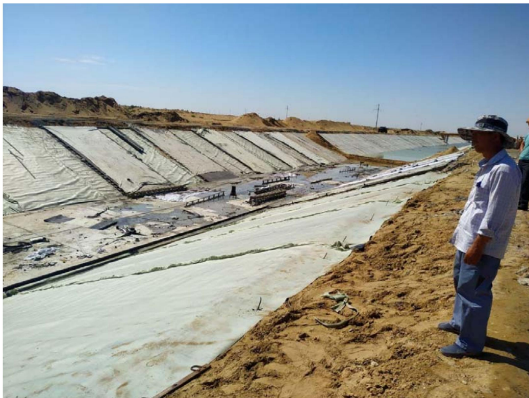
Фото: Бетонирование канала Бустан
