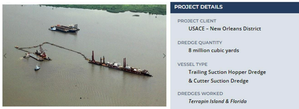
Рисунок 5-25 Дноуглубительные работы на Хэд-оф-Пасса (слева) и сведения о проекте (Great Lakes Dredge & Dock Company)
