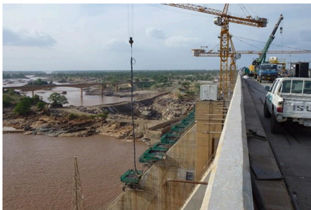
Рисунок 5-20 Повышение плотины Розейрес ( http://pf.bbrnetwork.com/ )
