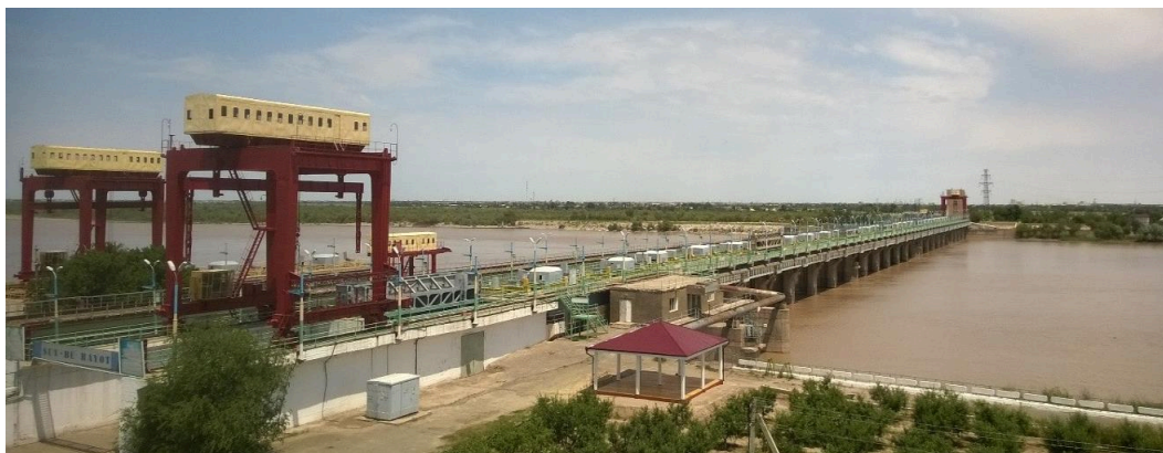
Рисунок 2-3 Тахияташский гидроузел, расположенный ниже по течению от ТМГУ, в Каракалпакстане (УзНКИД, 2020)
