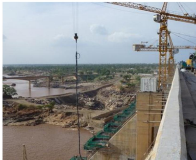
Рисунок 3-10 Повышение плотины Розейрес в Судане (изображение слева - http://pf.bbrnetwork.com/Projects/Manager/media287A-INFOslider_medium.jpg ) и профиль повышения плотины Жушу в Китае (график справа - https://www.intechopen.com/Chapters/71980 )
