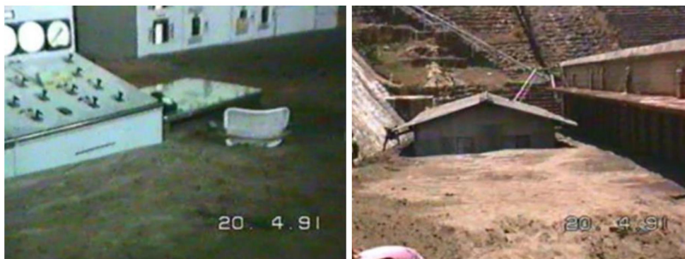
Рисунок 3-20 Затопление илом внутри (слева) и вокруг здания электростанции (справа) в результате аварии, произошедшей при промывании наносов в водохранилище Пиллур в Индии (Гири и др., 2019)
