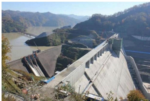
Рисунок 3-9 Опыт по наращиванию (перемещению) плотин в Японии: замена плотины Оюбари более крупной Юбари Шупаро (изображение слева – получено от И. Шимизу) и наращивание плотины Маруяма при помощи Шин-Маруяма (график справа - https://doi.org/10.20965/jdr.2018.p0585 )
