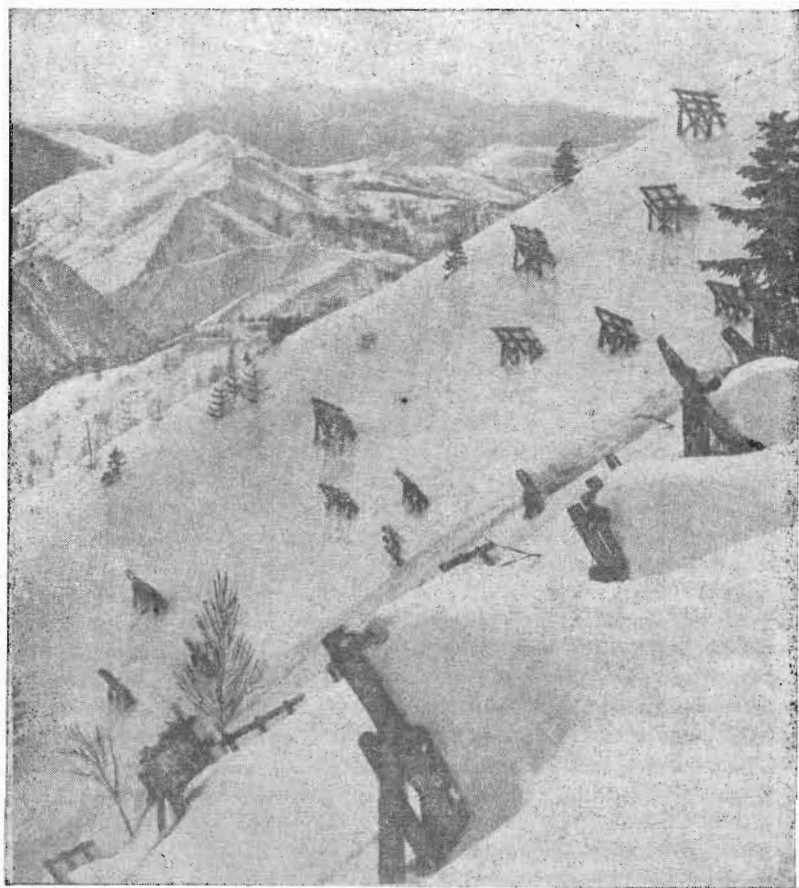
Рис. 10.2. Деревянные снегоудерживающие щиты
