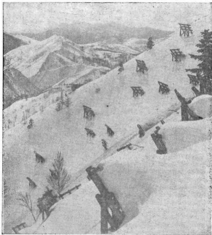
Рис. 10.2. Деревянные снегоудерживающие щиты
