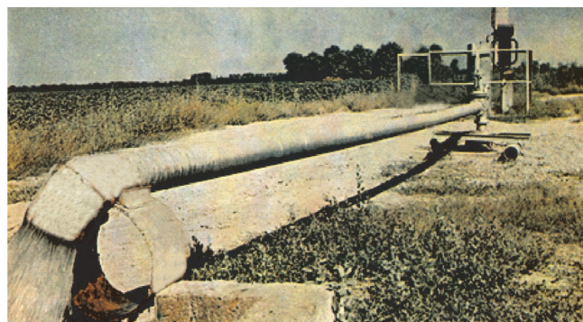
Рис.1. Оголовок скважины вертикального дренажа
