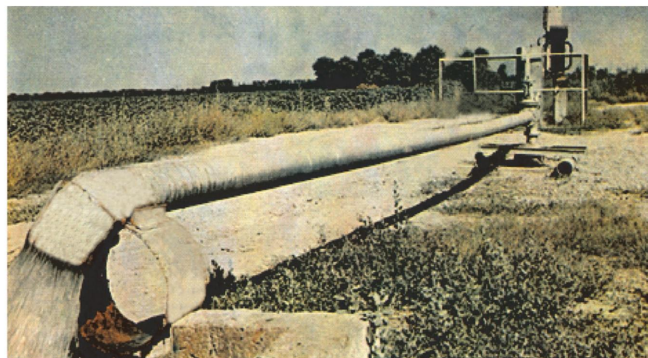
Рис.1. Оголовок скважины вертикального дренажа
