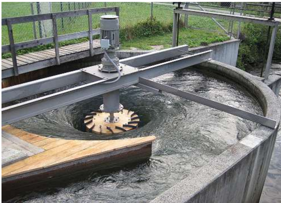
Рис.1 Водоворотная микро ГЭС
