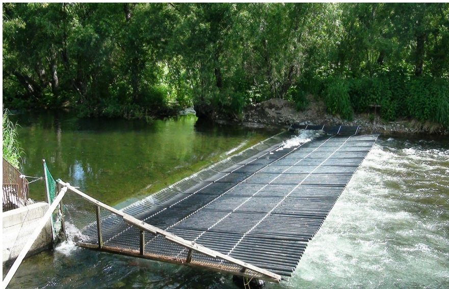
Фото 24. Устройство для заготовки производителей лососей для целей искусственного воспроизводства на притоке реки Большая. (Камчатский край). (Фото Яковлев С.В.)
