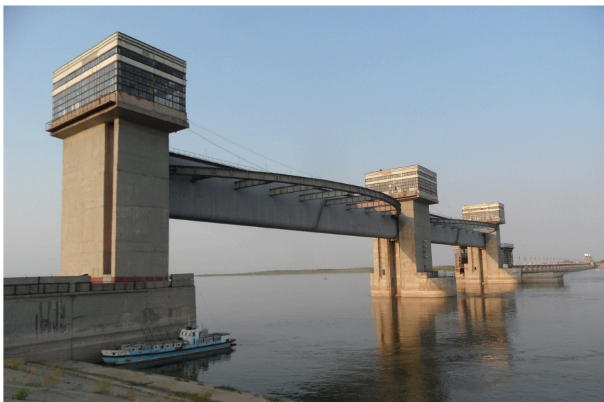
Фото 2. Гидростроительство (Астраханский вододелитель, Астраханская область). (Фото Яковлев С.В.)
