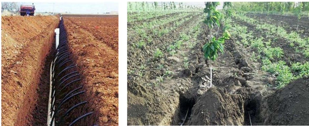
Рис 2.25 Система внутripочвенного орошения
